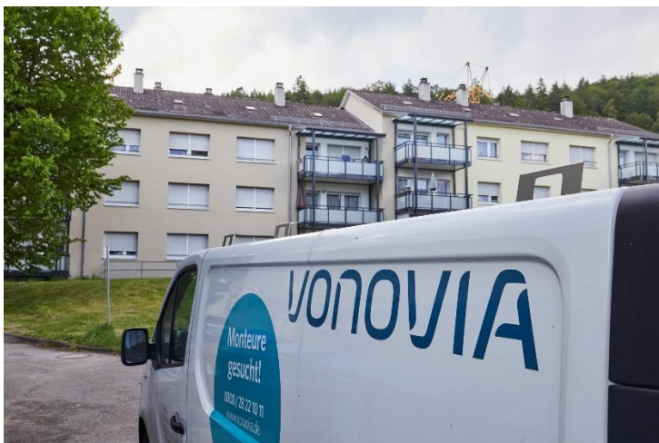
Auch Maßnahmen zur Verbesserung der Wohnqualität stehen im Vordergrund: Unter anderem werden die alten Balkone abgebrochen und durch neue Vorstellbalkone ersetzt und vergrößert. Quelle: Vonovia
